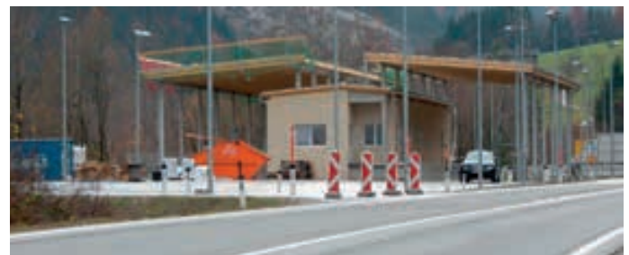
Kontrollstelle Leisach in der Bauphase
