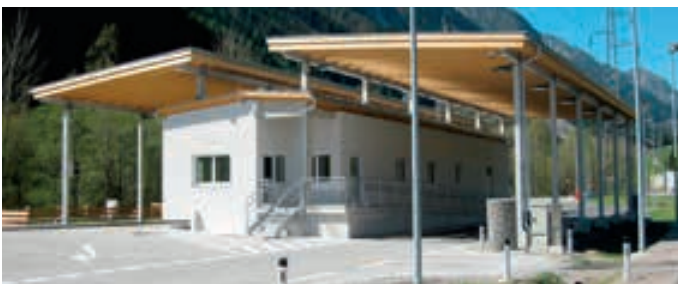
Kontrollstelle Leisach nach der Fertigstellung
